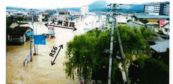
肱川水系肱川の浸水状況（愛媛県 大洲市）
