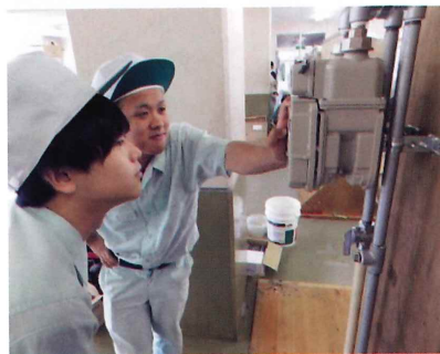
液化石油ガス設備実技講習 (設備の検査)
