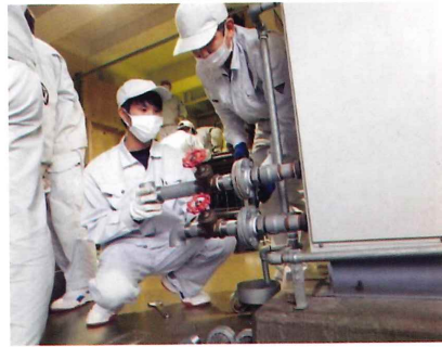
配管施工実習 (模擬家屋設備実習)
